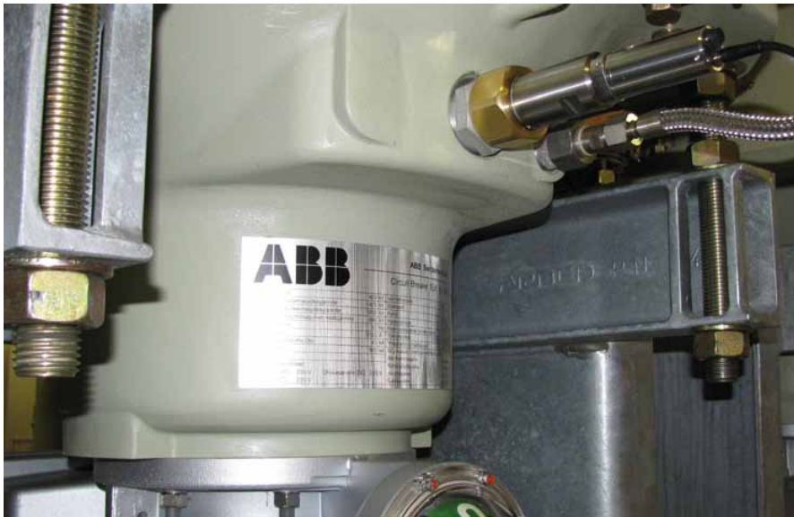
Abb. 5. Montage eines Multiparameter-Messwertgebers (DPT145) direkt im Hauptgastank (25.03. – 14.04.2010). Das Gasvolumen in der Messzelle beträgt ungefähr 20 ml.
