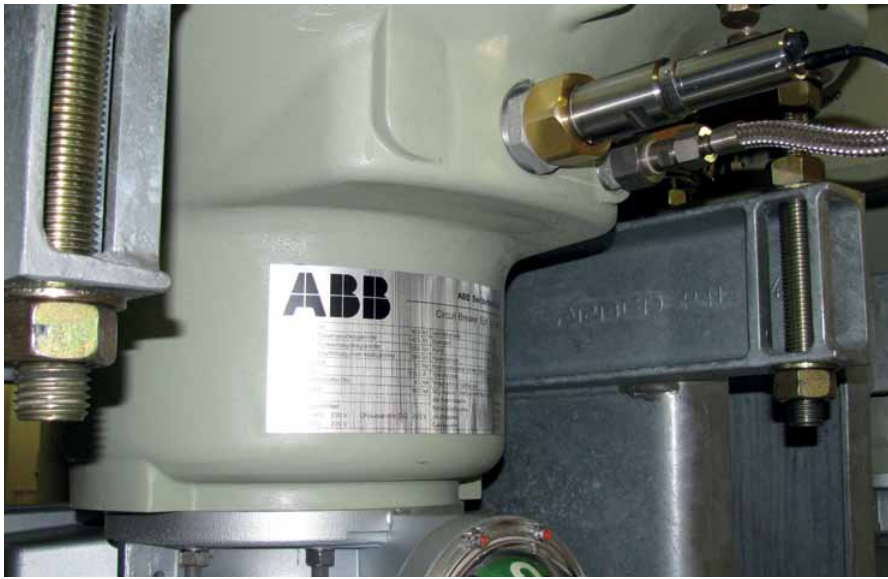
图5: 直接将露点-压力-温度传感器 (DPT145) 直接安装在气室上 (2010年3月25日至4月14日)。测量单元中的气体大约有20毫升。
