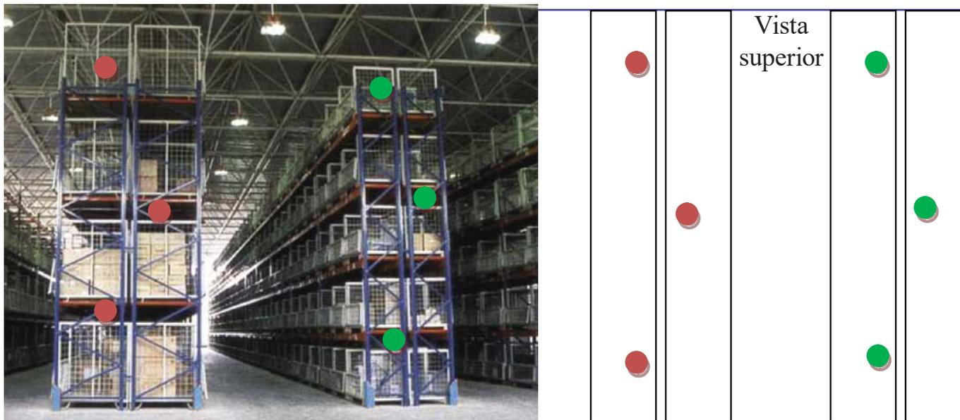
Figura 2: Os sensores colocados no meio dos racks refletem melhor as temperaturas dos produtos. Neste exemplo, nove sensores estão localizados em cada rack duplo nesse depósito que mede 30 m x 30 m x 15 m.
