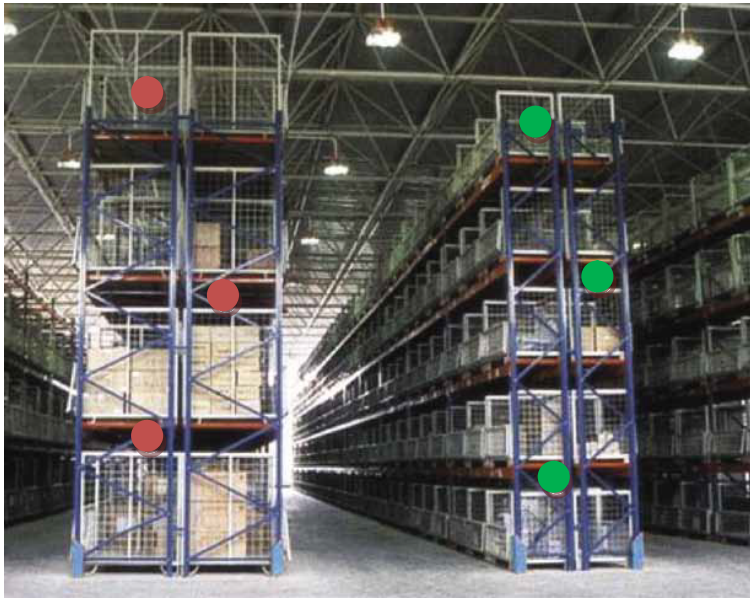
Figura 2: Los sensores colocados en el centro de los soportes, reflejan con mayor precisión las temperaturas de los productos. En este ejemplo, nueve sensores están ubicados en cada soporte doble de este almacén, midiendo 30 metros por 30 metros por 15 metros.
