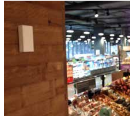
Transmisor de la serie Vaisala HMW90 sobre la pared.
