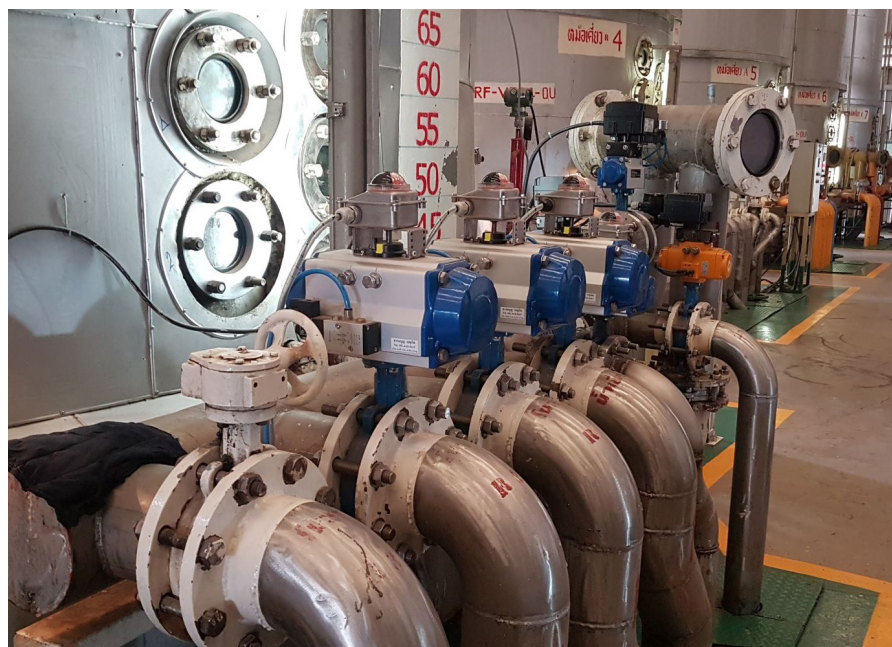
Immagine 2: Valvole di alimentazione dello sciroppo.
