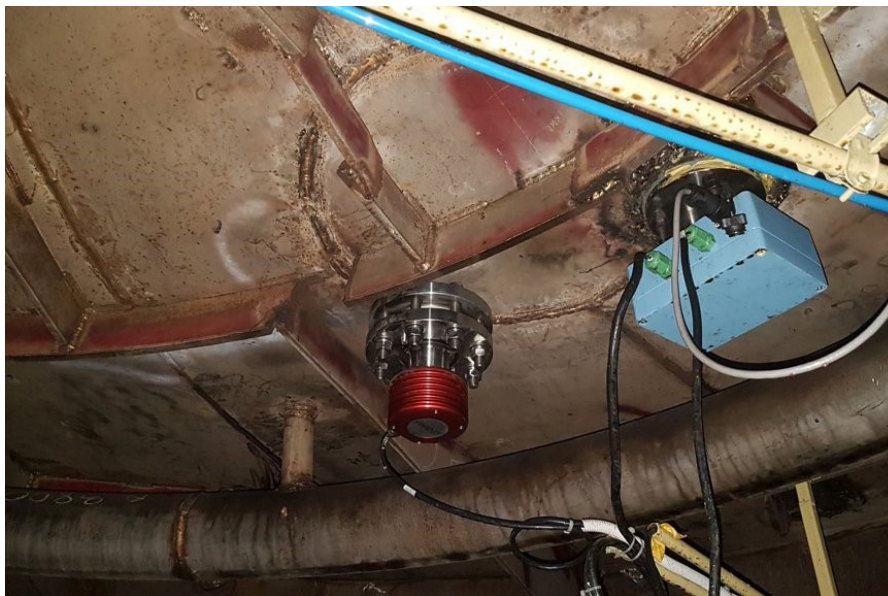
Immagine 3: Vasca inferiore con un sensore rifrattometro e un misuratore a microonde. Lo scioppo viene alimentato alla vasca tramite un anello di alimentazione.
