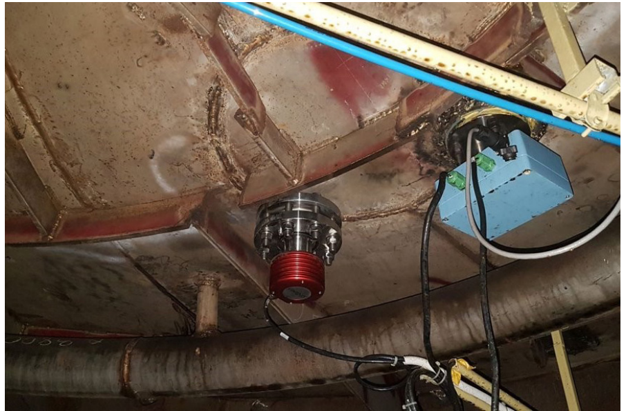
Kuva 3: Astian pohja, jossa näkyy refraktometrin anturi sekä mikroaaltomittari. Sokeriliuos syötetään astiaan syöttörenkaan kautta.
