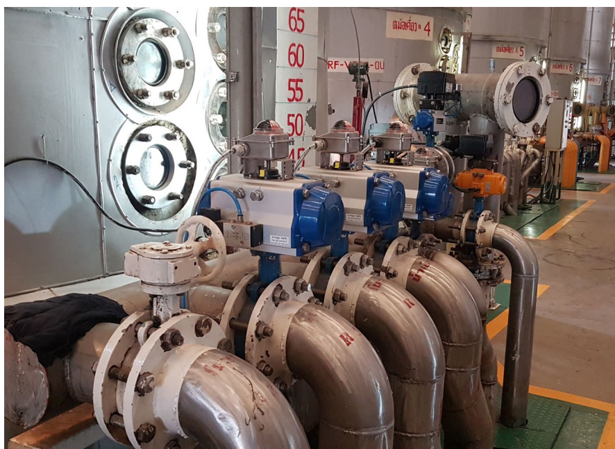
Kuva 2: Sokeriliuoksen syöttöventtiilit.
