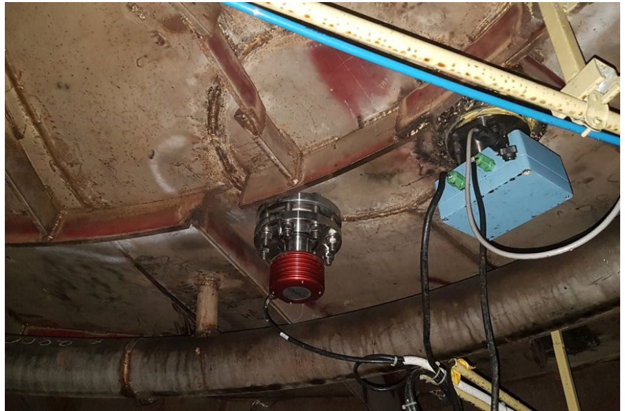
Bild 3: Kocherboden mit einem Refraktometersensor und einem Mikrowellen-Messgerät. Sirup wird dem Kocher über einen Zufuhrring zugeführt.
