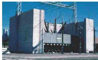
Die Onlinemessung der Ölfeuchte ist ein wichtiger Bestandteil von umfassenden Programmen zur vorbeugenden Wartung von Transformatoren.
