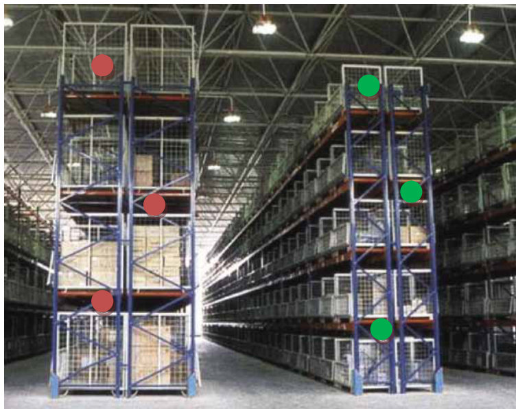
図 2：ラックの中央に配置されたセンサは、製品の温度をより厳密に反映します。この例では、30m×30m×15mの倉庫に置かれたダブルラックにそれぞれ9台のセンサが配置されています。
