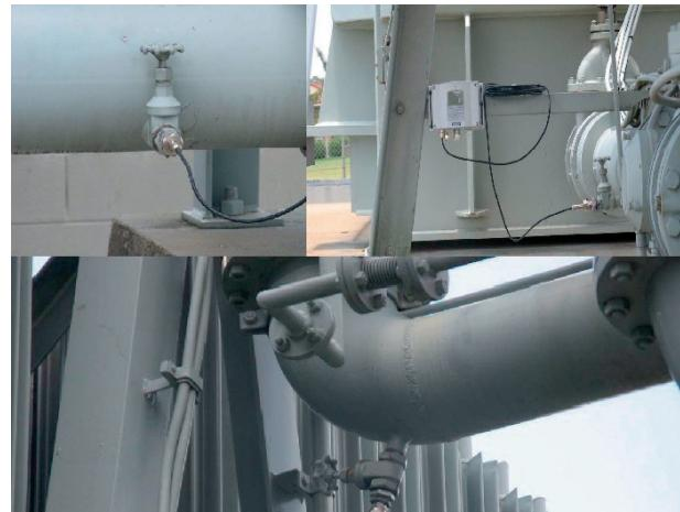
维萨拉MMT338油中水分与温度变送器探头沿油的冷却回路安装。上方的传感器提供温度和湿度水平的实时数据，而下方传感器指示当油液流回变压器油箱时在散热器上油冷却的程度，以及油的相对水分饱和度高到什么程度。
