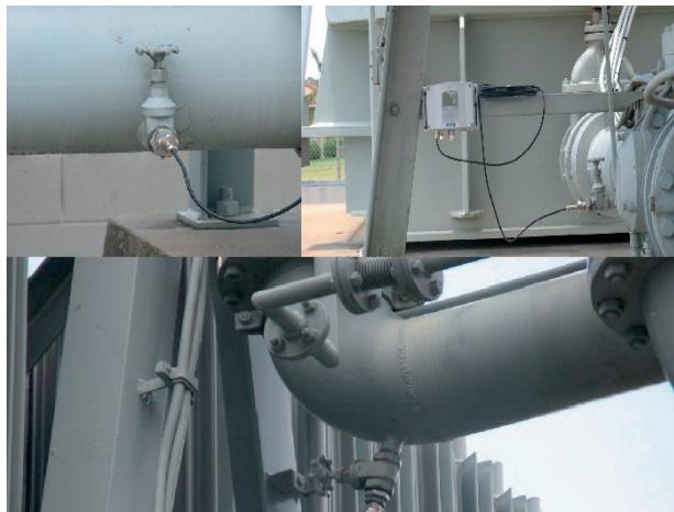
Las sondas de los Transmisores de humedad y temperatura del aceite de Vaisala MMT338 se instalan en toda la circulación de enfriamiento del aceite. El sensor en la parte superior brinda datos en tiempo real sobre la temperatura y el nivel de humedad, mientras que el sensor inferior muestra cuánto aceite se enfriá en el radiador y qué tan alta es la saturación relativa de humedad del aceite, a medida que fluye de vuelta al tanque del transformador.
