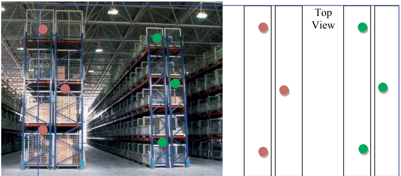
Figura 2. Sensores colocados no meio das prateleiras refletem a real temperatura do produto. Neste exemplo, nove sensores estão localizadas em cada rack duplo deste almoxarifado medindo 30 metros por 30 metros por 15 metros.
