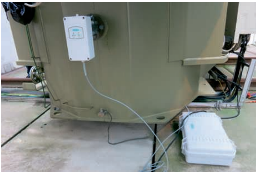
Installation eines MHT410 Prototyps in einem Messventil bei Vantaan Energia.
