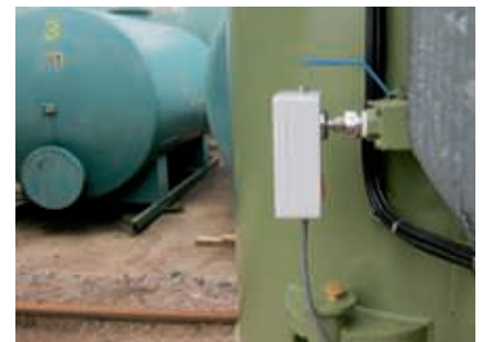
Installation eines MHT410 Prototyps in einer Kühlleitung.
