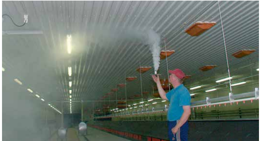
Ilman kierron havainnollistamiseen eläinsuojassa käytetään savua, jotta voidaan optimoida ilmanvaihtojärjestelmän suunnittelu.
